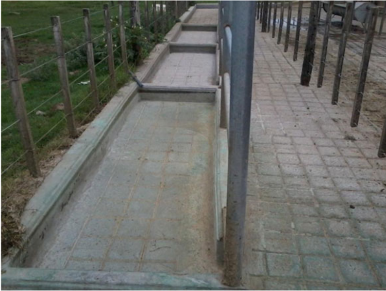
Foto 3: Existe una gran diversidad de diseños de pediluvios, en muchos casos combinando uno o más "lavapatas" antes del baño medicado.
