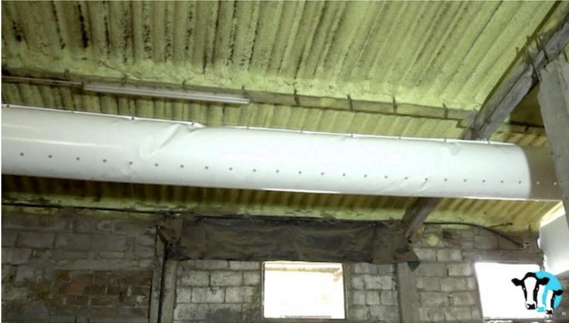
Tubos de ventilación por presión positiva instalados en la Cooperativa Grille.
