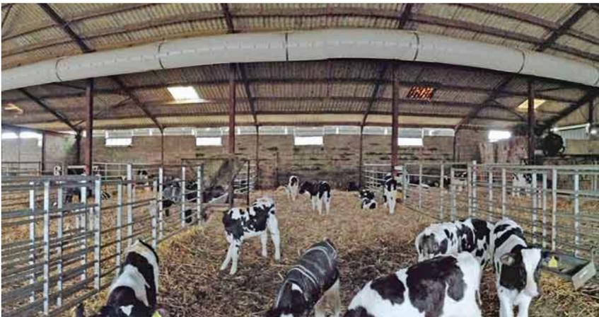
Figura 6. Retroadaptación de un ventilador mecánico de tubo de ventilación de presión positiva a un gran cobertizo de ternero.
