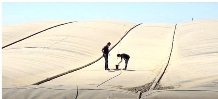
Para los componentes dietéticos que no pueden ser completamente digeridos por el estómago de una vaca, los digestores de lácteos utilizan una variedad de bacterias para descomponer el estiércol en condiciones anaeróbicas. Esto proporciona una opción para el tratamiento sostenible de residuos. El proceso no solo reduce las emisiones de gases de efecto
