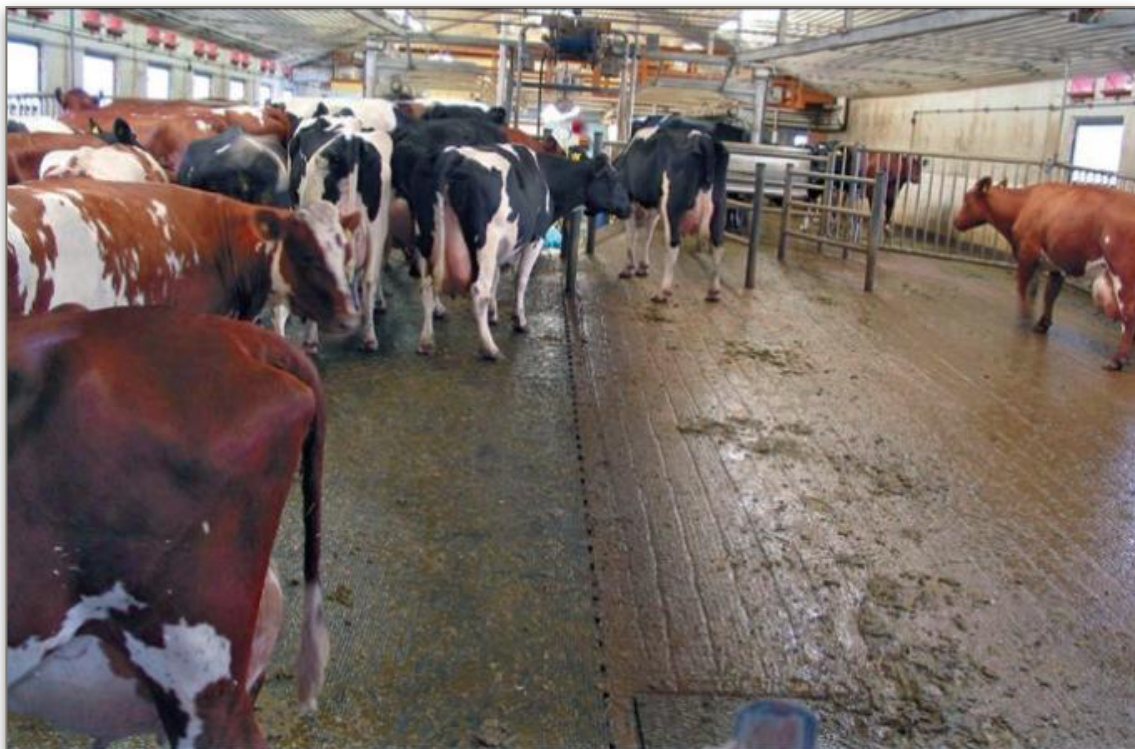
Figura 2. Corral de espera con suelo de goma sobre el hormigón.
