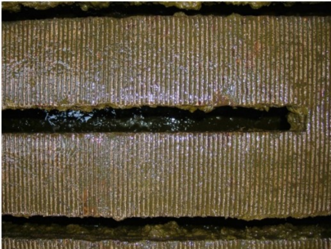
Figura 7. Suelo acanalado. El hormigón está ranurado en 2 mm de ancho y de profundo. De esta manera, las vacas tendrán un buen agarre al andar.
